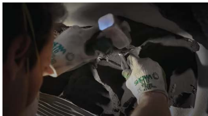
13. ábra: Betonozás utáni roncsolásos zsaluzat eltávolítás (Mashable, 2018)
