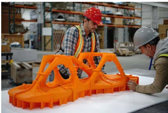
16. ábra: Nyomtatott zsaluzat összeszerelése (ball) és roncsolásos kizsaluzás (jobb) (Jasta, 2021)
