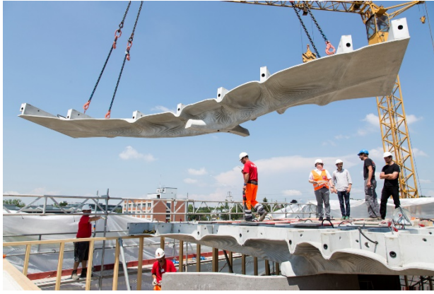
14. ábra: Födémpanel beemelése (ball) és kész födém szerkezet (jobb). (Pintos, 2021)
