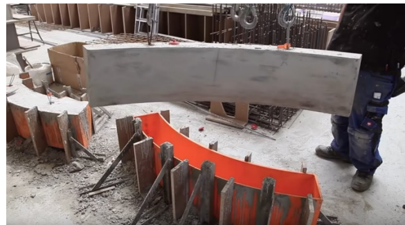
10. ábra: Ablak keret zsaluzatnyomtatás (ball), kész elem kizsaluzás (jobb) (DAVIES, 2017)
