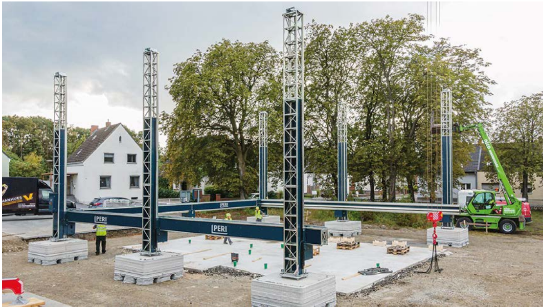
1. ábra Építési helyszínen felállított BOD2 nyomtató
