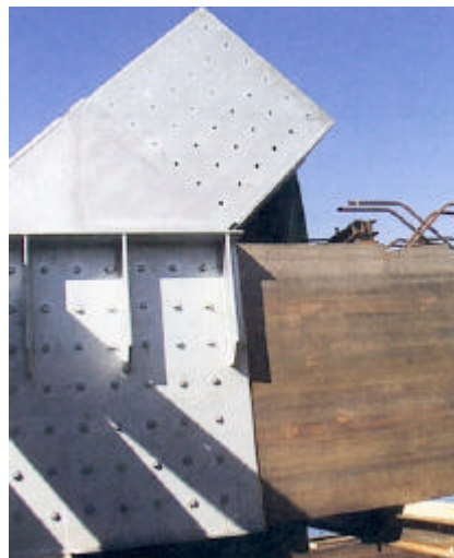
14. kép: A fotartó és a ferde helyzetű faelemek kapcsolata
