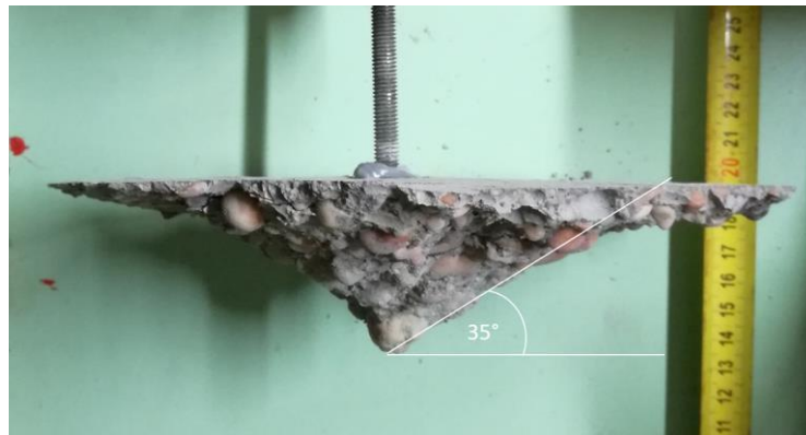
5.9. ábra: Kúpszerű kiszakadás tűzkárosodott betonban
